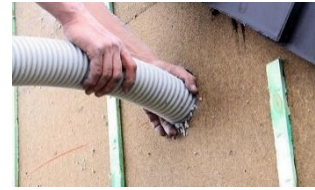
Figuur 3.8-13: Inblaasisolatie
