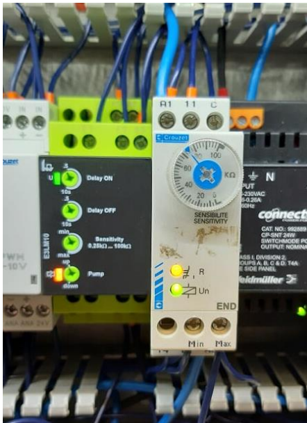
Figuur 5.2-6: Controlerende relais niveausensor buffervat
