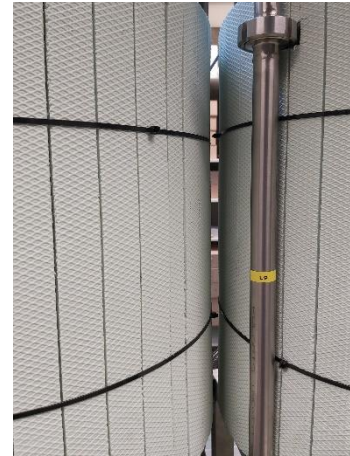
Figuur 3.8-7: Kleine afstand tussen het buffervat en de kookketel
